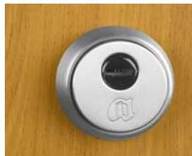
El sistema de accionamiento por el exterior de la puerta, está formado por un escudo de seguridad antitaladro.
